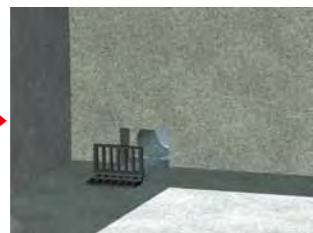
②既設のストレーナを外し、必要に応じて下地を調整します。
